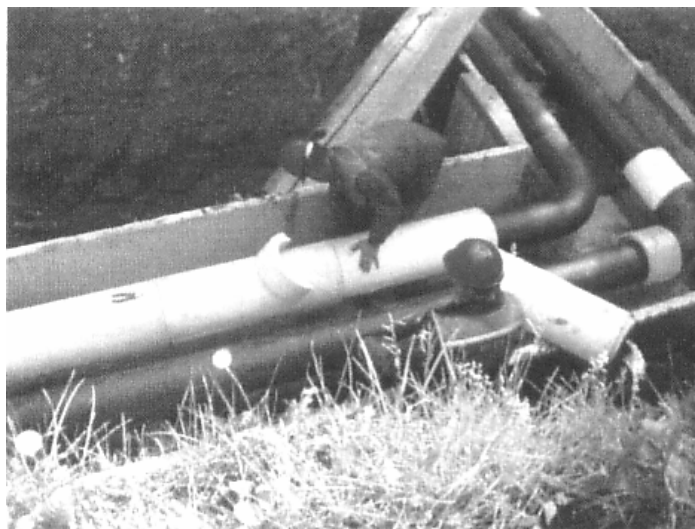
Рис. 5.2. Фасонные теплоизоляционные изделия из пенополиуритана
