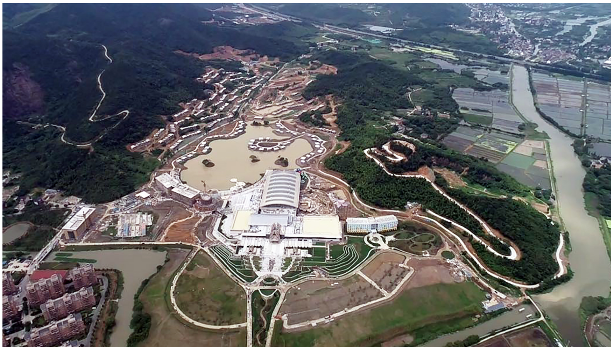
Рисунок 1 – Процесс строительства Moganshan Kaiyuan Senbo
